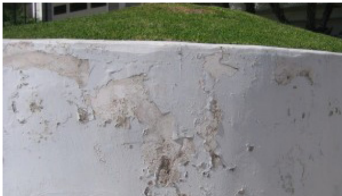
그림 3: 치장벽토 벽면 위 수분으로 인한 손상
