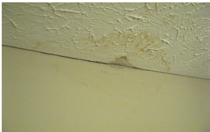
图 2: 由于水破坏导致涂层起皱。
