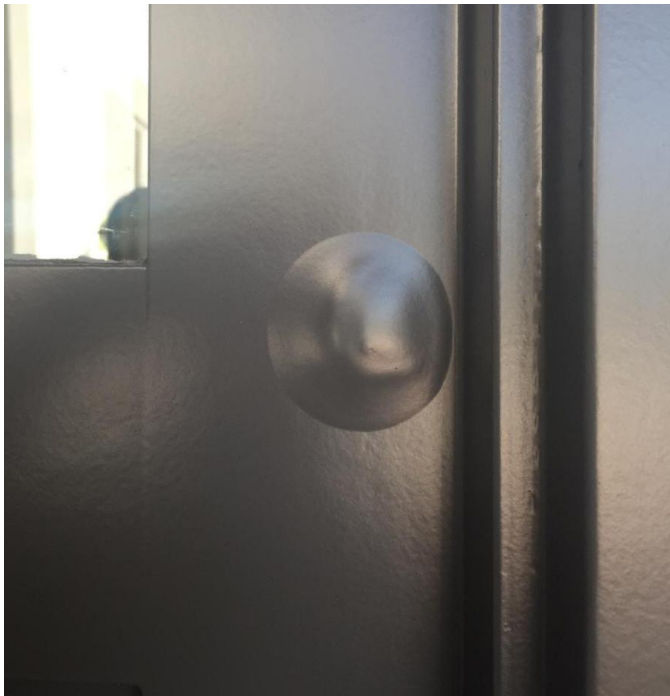
Figura 3: Ampollas de pintura de color oscuro.
