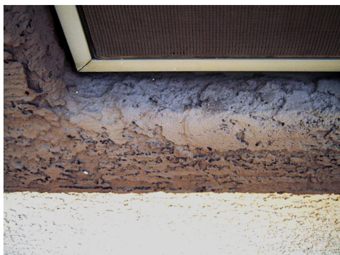
图 1: 深色油漆在水平表面上的过早降解。
